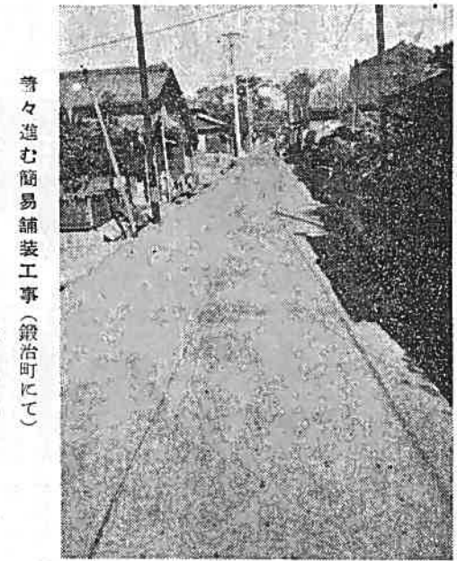
等々進む簡易舗装工事(鍛冶町にて)
