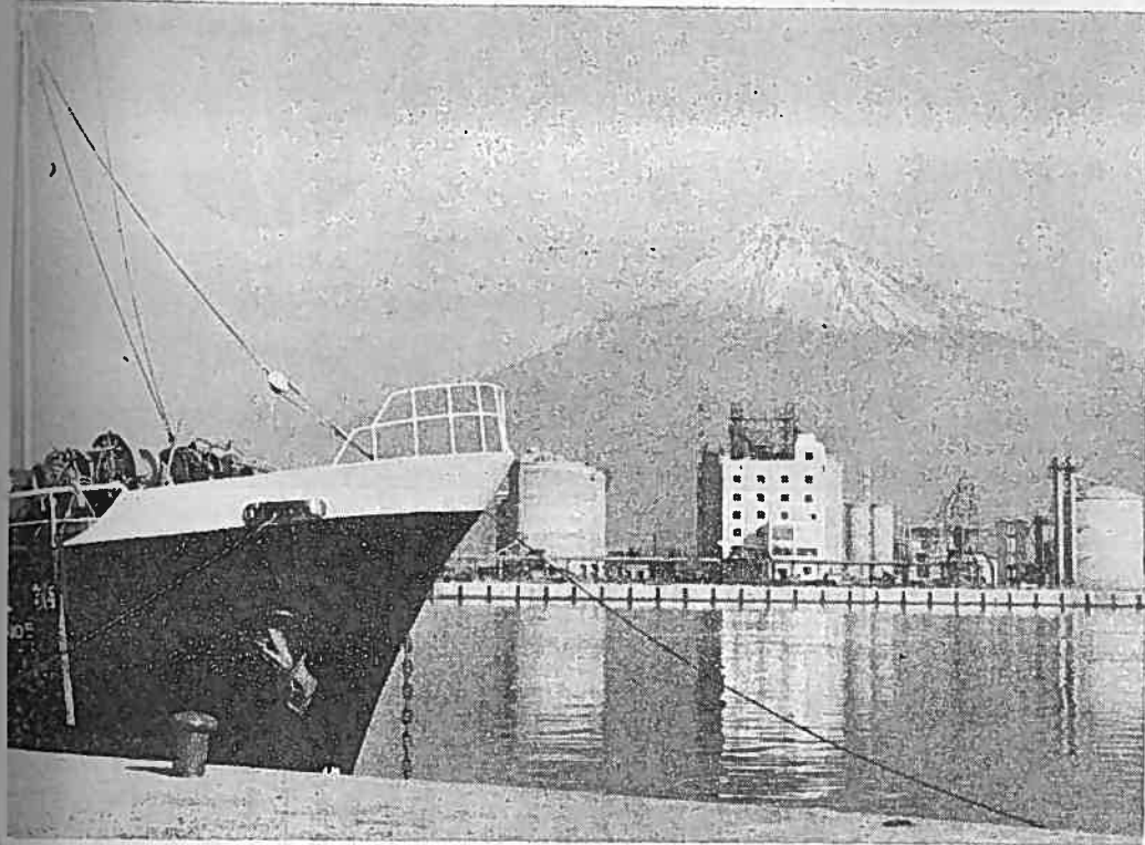
近く1万トンの大型船が入る田子浦港 一旭化成の専用埠頭にてー
