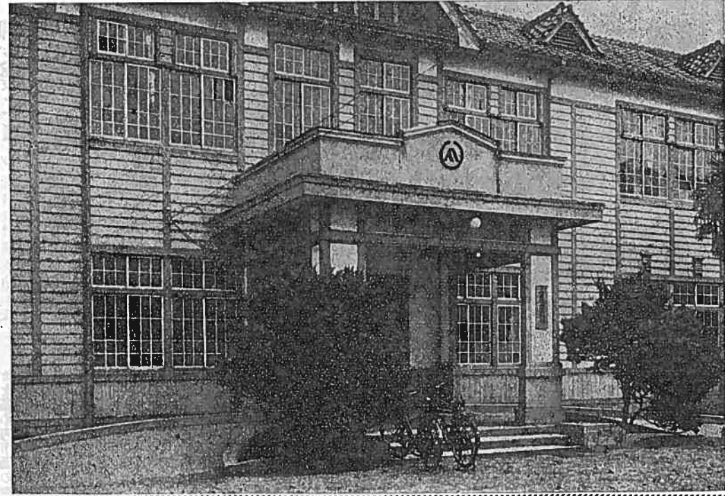
〔写真は富士市役所庁舎〕
