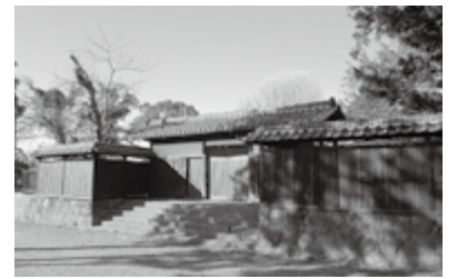
門と塀の外観
