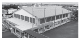
富士川第一小学校屋内運動場
