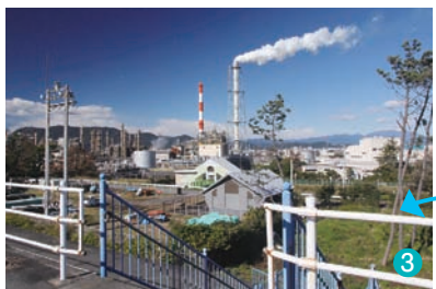
目印の煙突にたどり着いたら、堤防を下り、「入道樋門公園」に立ち寄ります。
