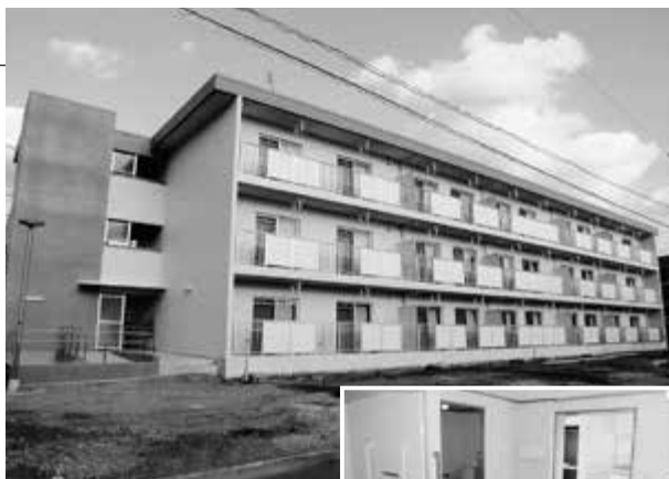
▲完成した雲雀ヶ丘団地 車いす対応の部屋▶
