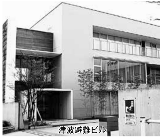
市内3か所に建設された津波避難タワー (写真は鈴川港公園)
