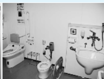
●庁舎1・2階トイレ 1階・2階それぞれの男子用・女子用トイレを改修。あわせてファミリートイレを新設し、汚物流し（オストメイト）・ベビーシート・幼児用便器などを備えました。
