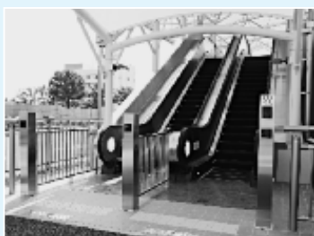
●庁舎東側屋外エスカレーター 市役所駐車場から2階市民課（正面玄関）へ、直接行くことができます。
