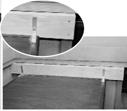
壁に板を打ちつけてから固定
