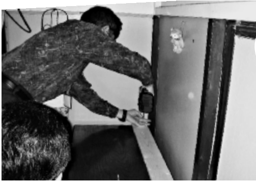
家具に板を打ちつけてから固定
