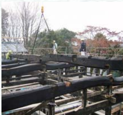
最も長いはりを解体する工事
