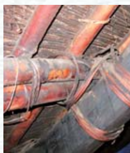
割り竹で縛った小屋組の様子(移築前)
