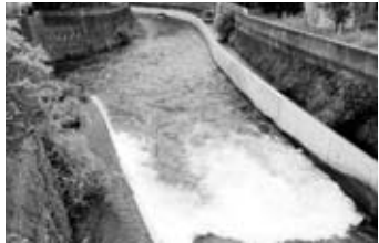
天間地区用排水路整備状況
