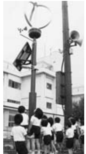
丘小学校に設置された太陽光と風力のハイブリット発電装置
