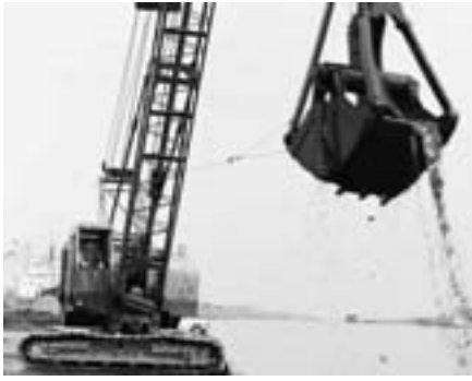
昭和46年 田子の浦港へド口処理作業
