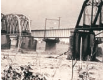
昭和57年 富士川鉄橋橋脚流失
