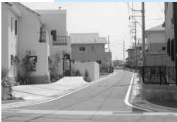
拡幅された広い道路
