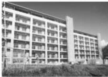
市営住宅岩本山団地B棟
