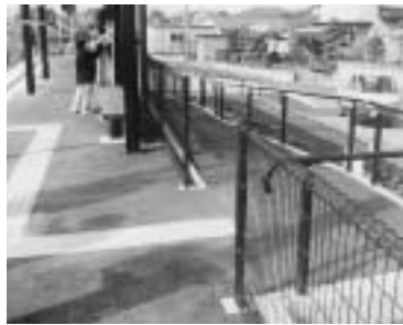
神谷駅に新しく設置されたスロップと点字ブロック
