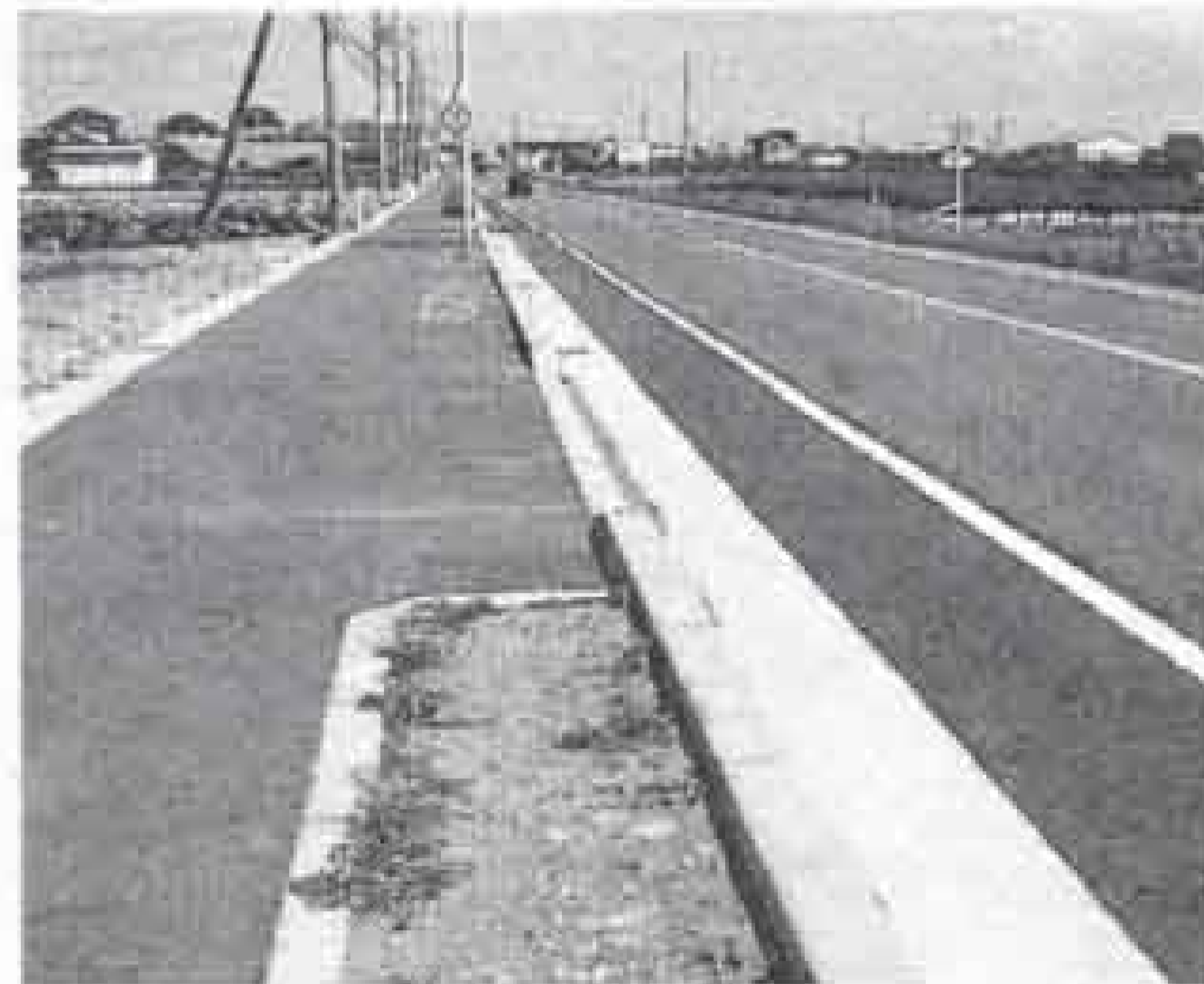
▲増川町交差点以東の沼津線の歩道
