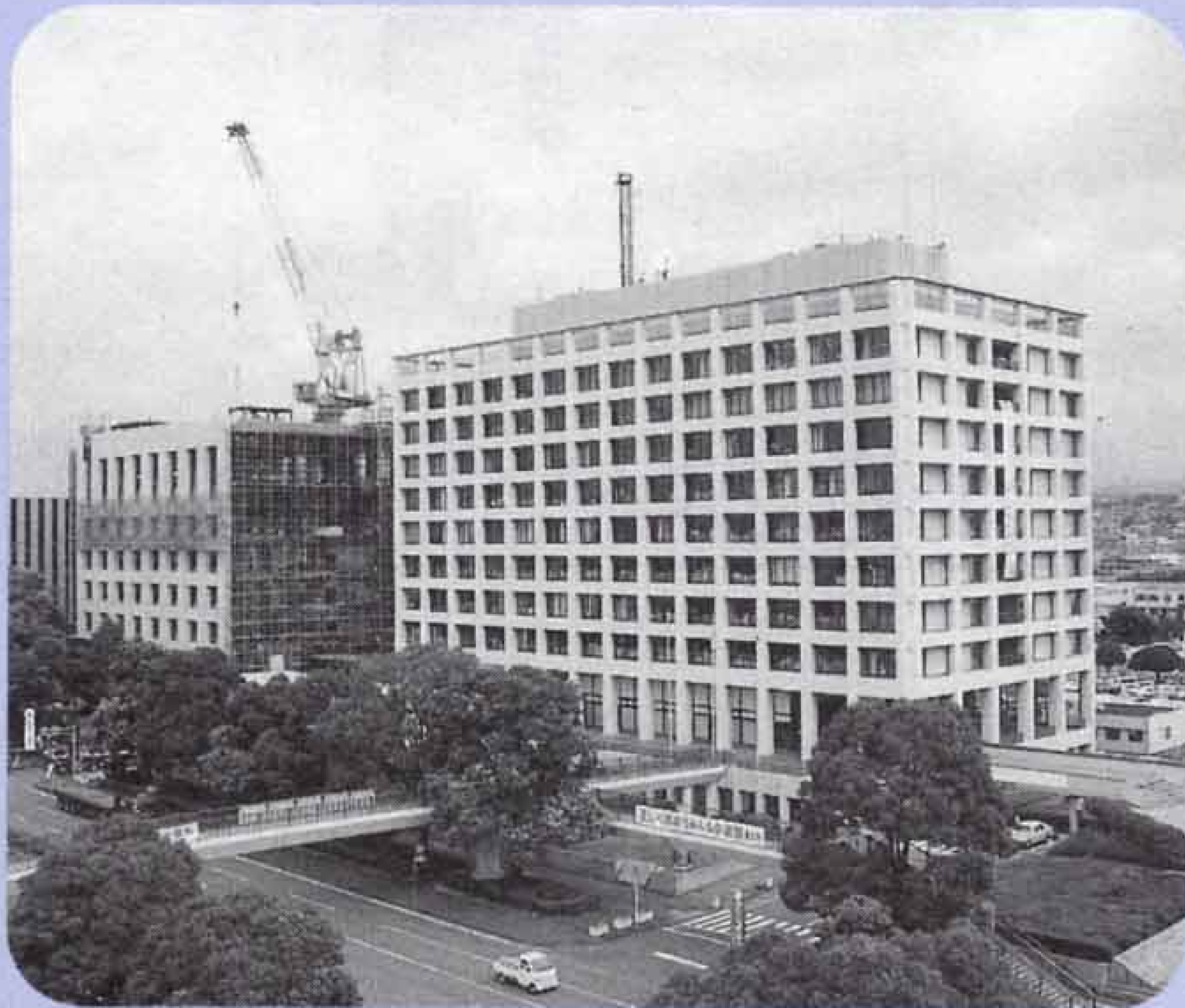
▲建設が進む新消防防災庁舎（平成13年3月完成予定） と市役所
