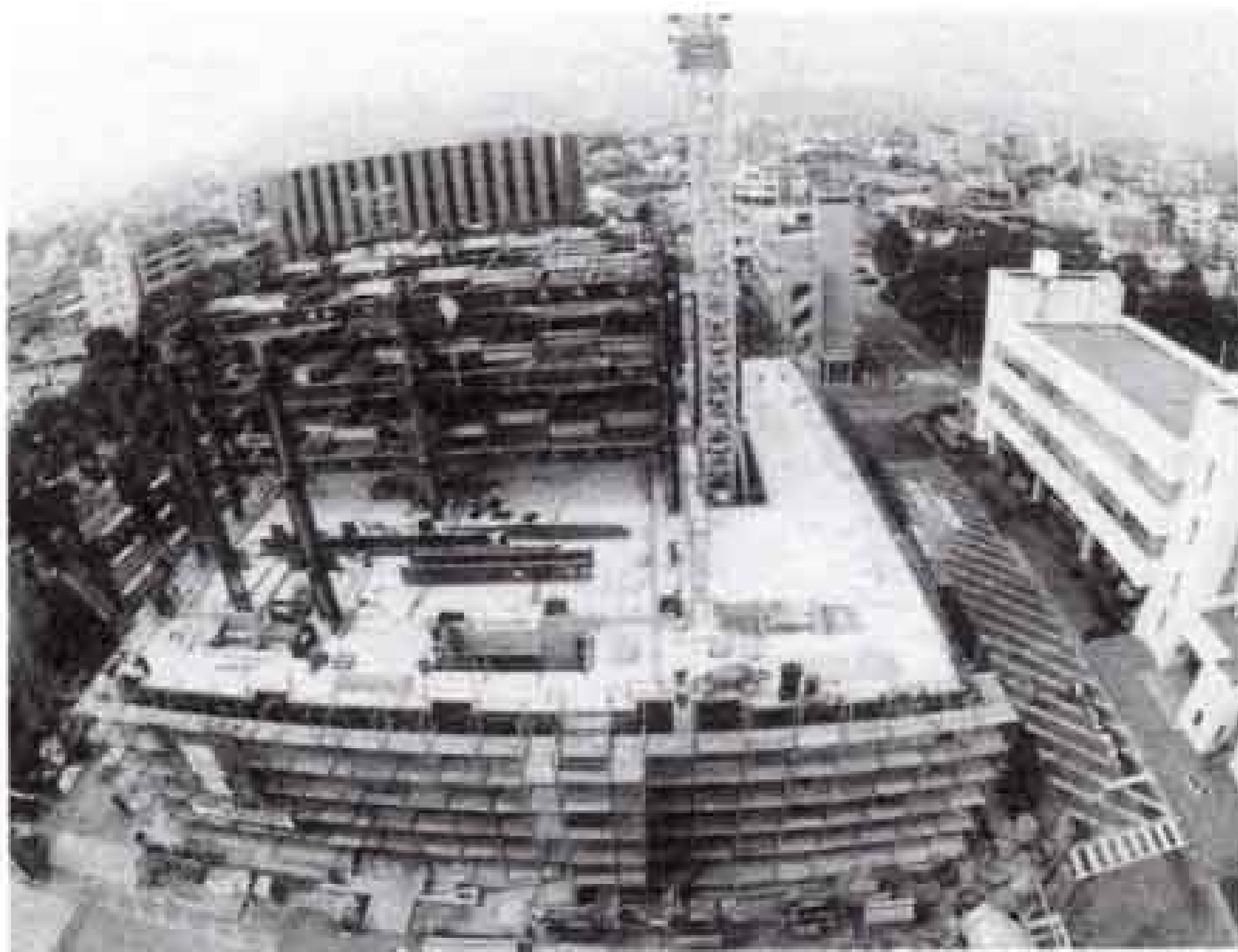
▶建設が進められている「新消防防災庁舎」
