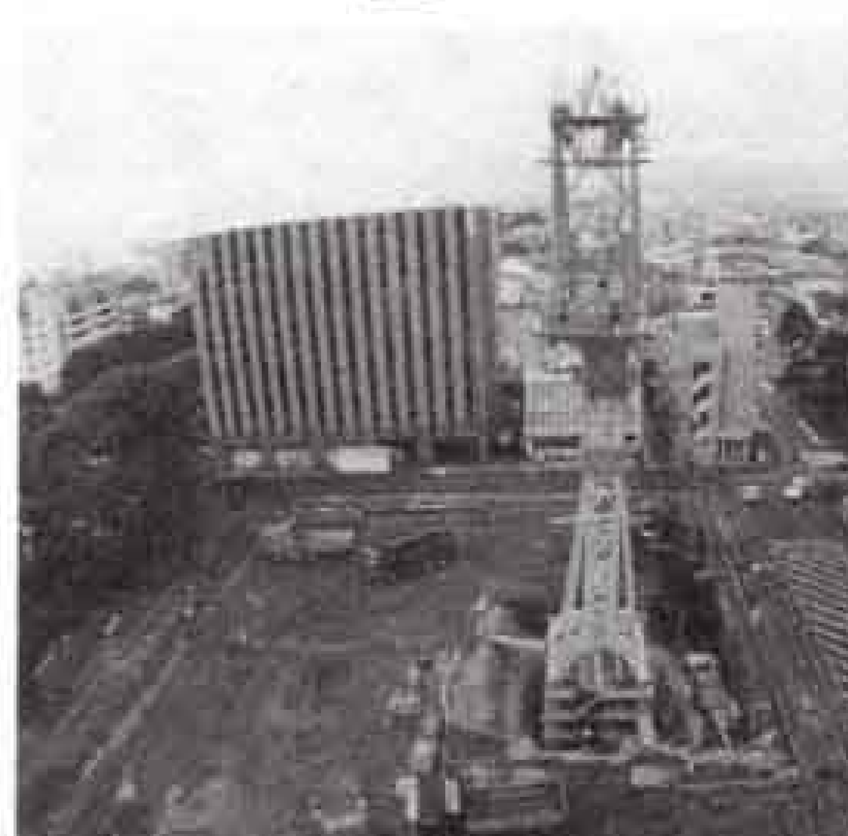
新消防防災庁舎は平成13年3月の完成を目指し工事が進められています。
