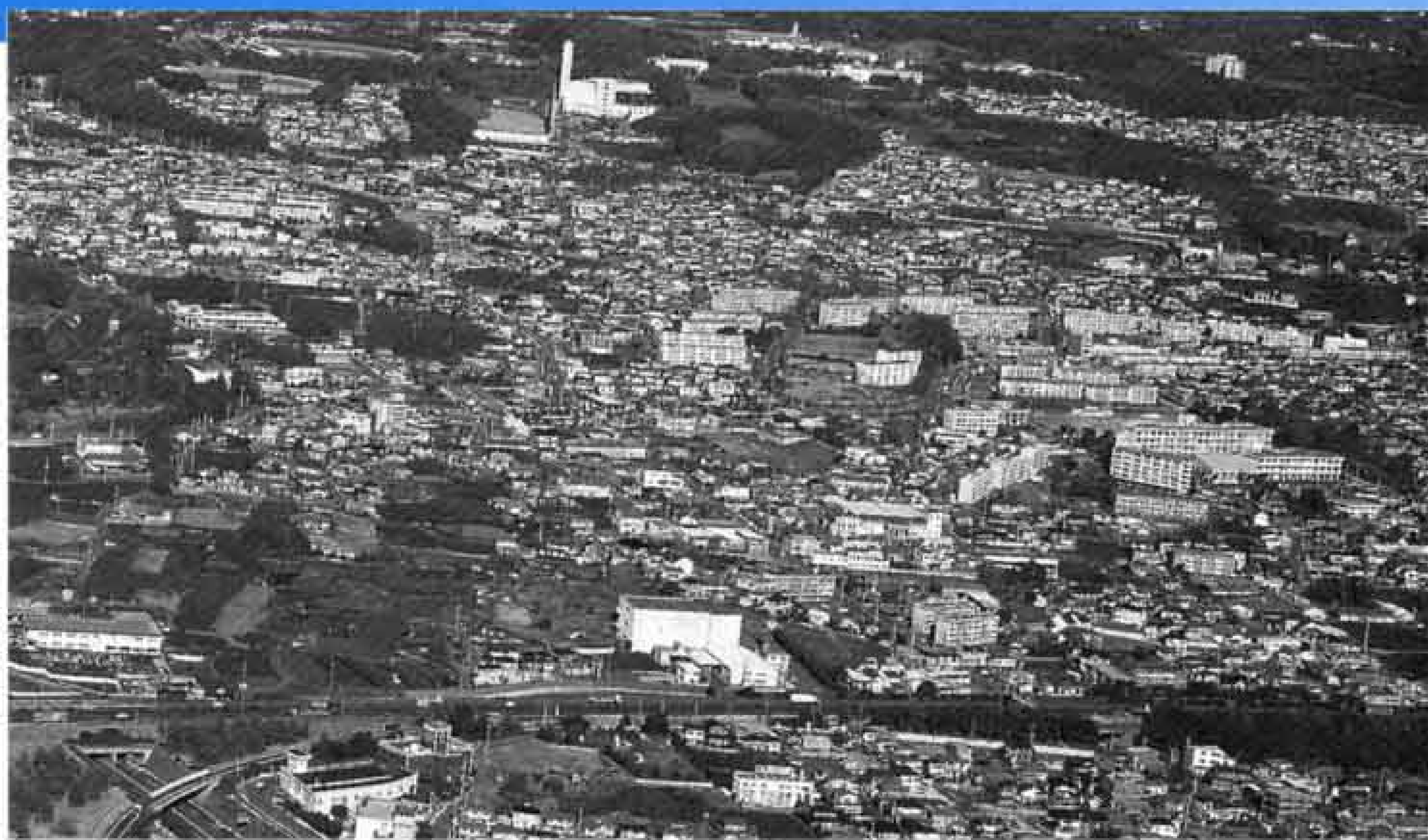
住宅地取得希望第一位の広見地区
