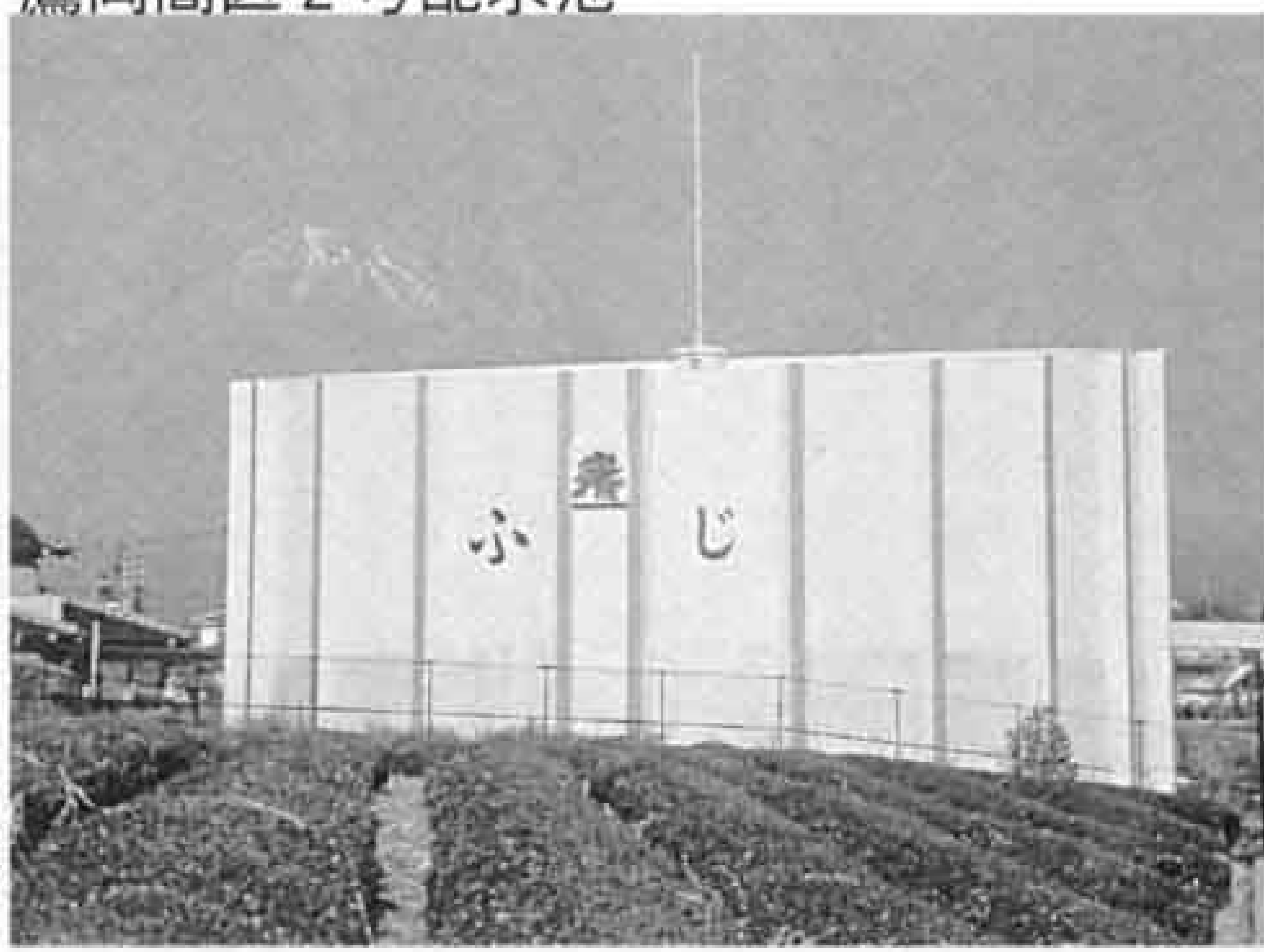
鷹岡高区2号配水池
