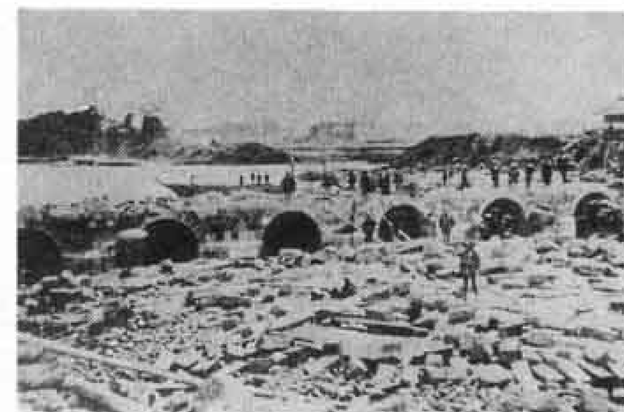
「浮島沼」展示資料 石水門の築造(明治16年)
