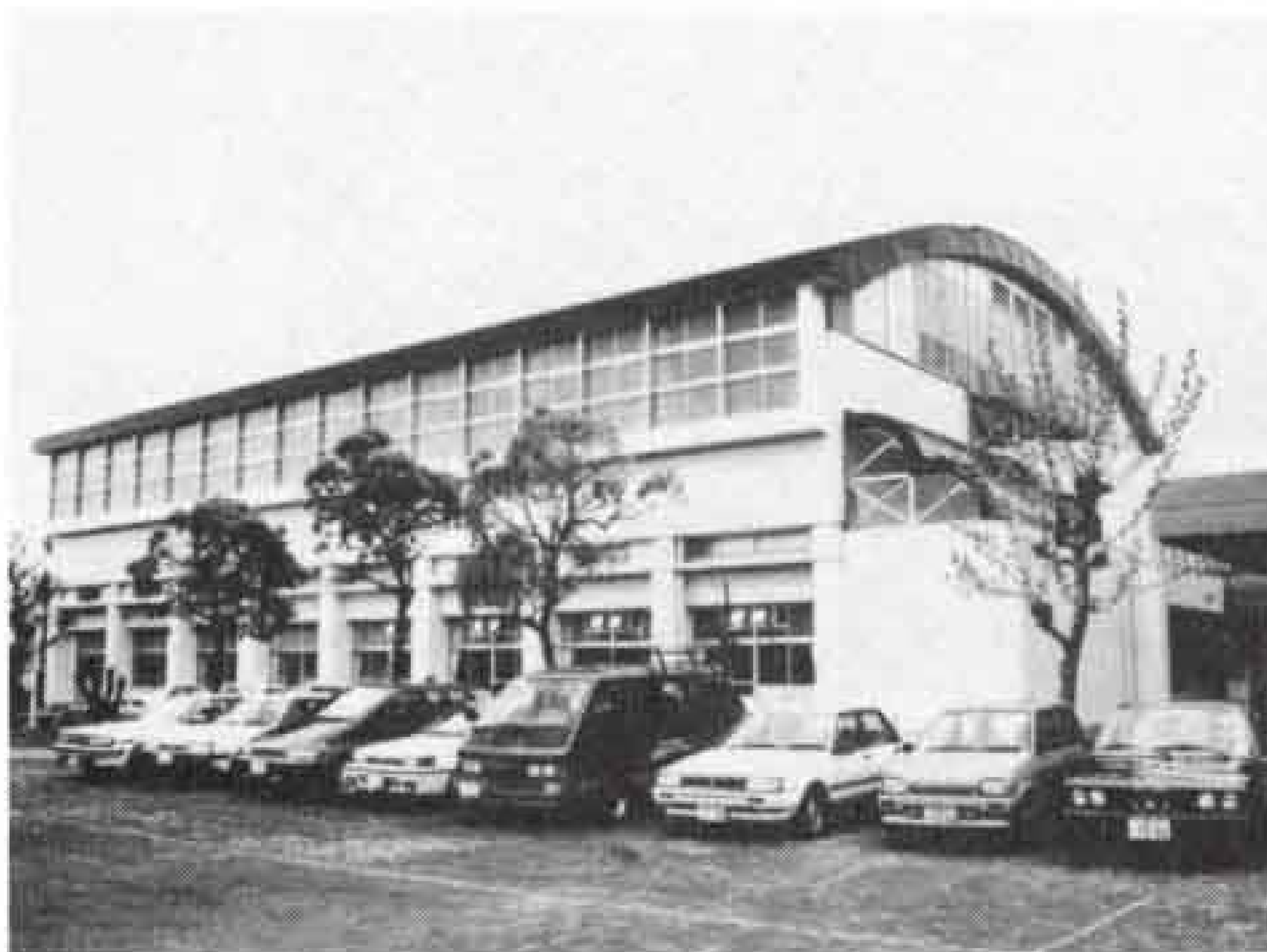
◁吉永第一小屋内運動場
