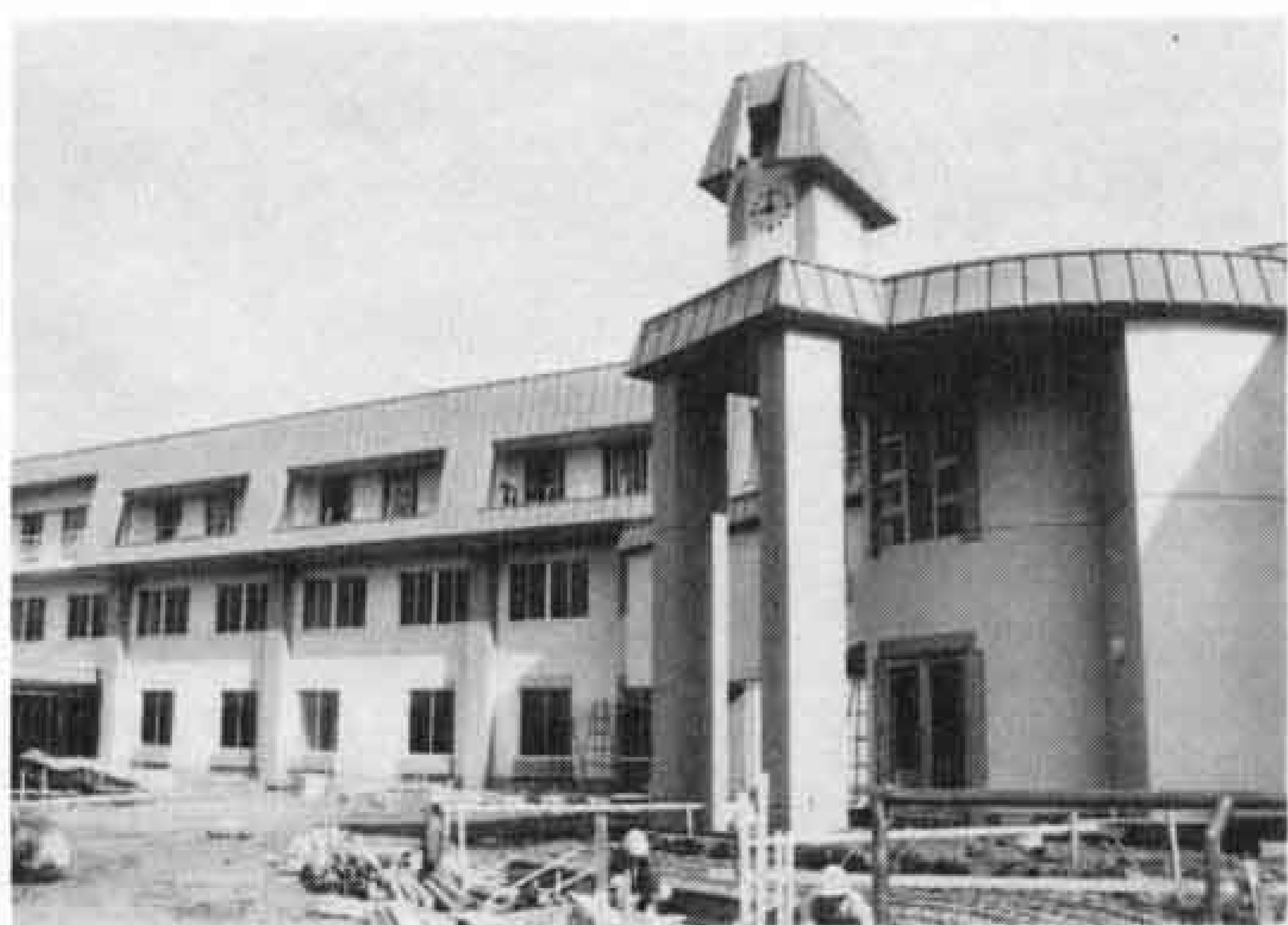
▷開学を間近に控え工事も最終段階の常葉学園富士短期大学
