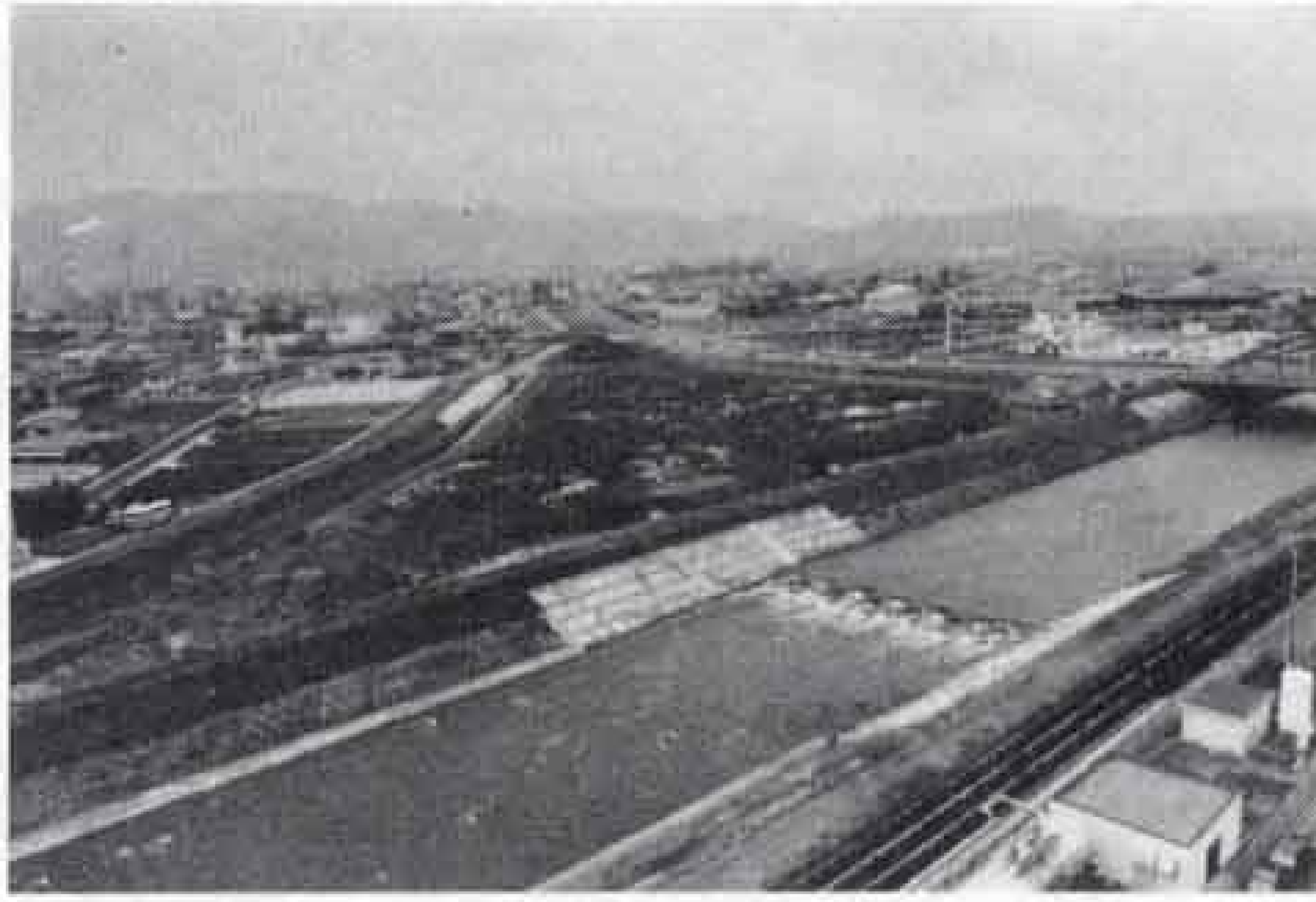
△中央の三角地帯が建設予定地(中央病院屋上から)
