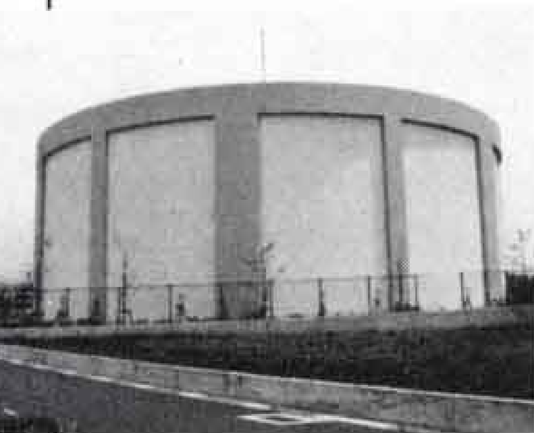
3月に完成した鷹岡地区配水池
