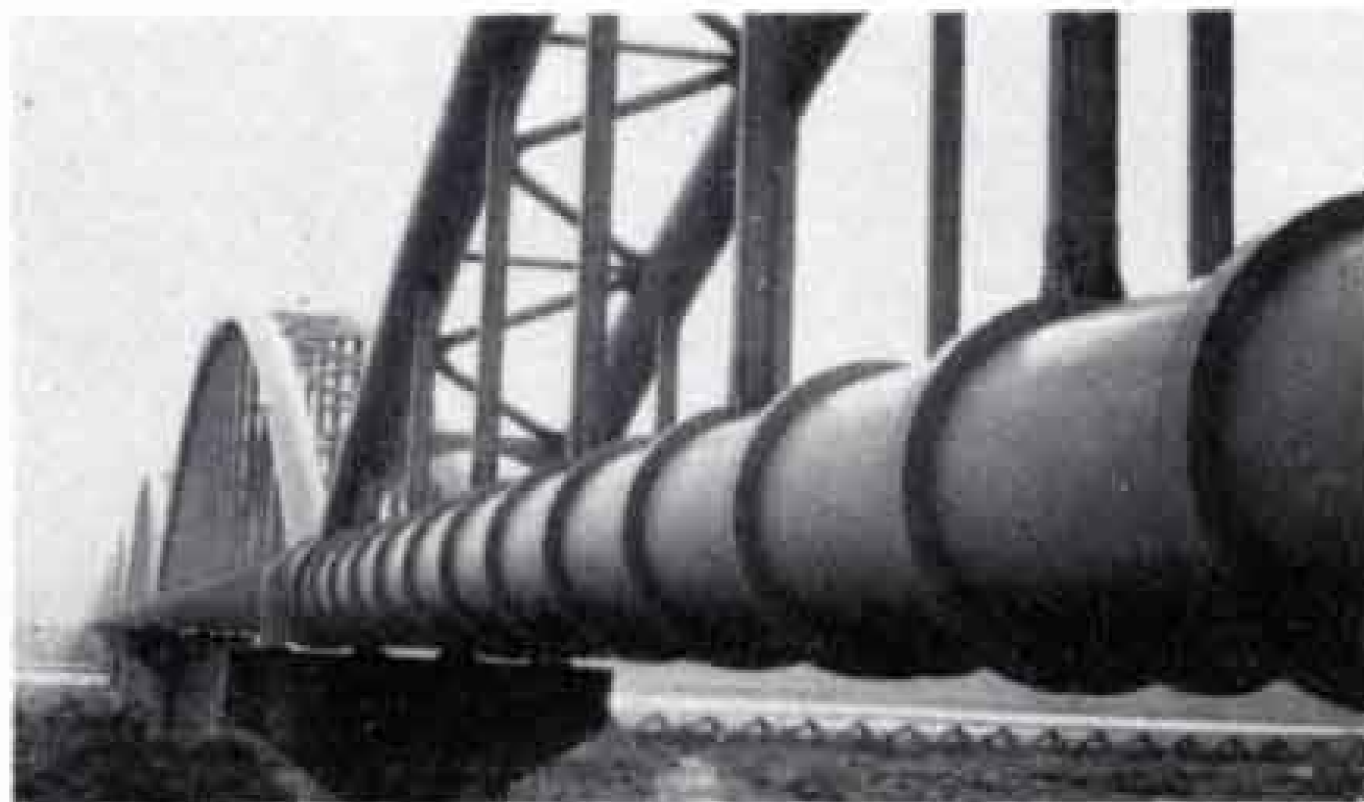
△東洋一の東駿河湾工業用水管橋
