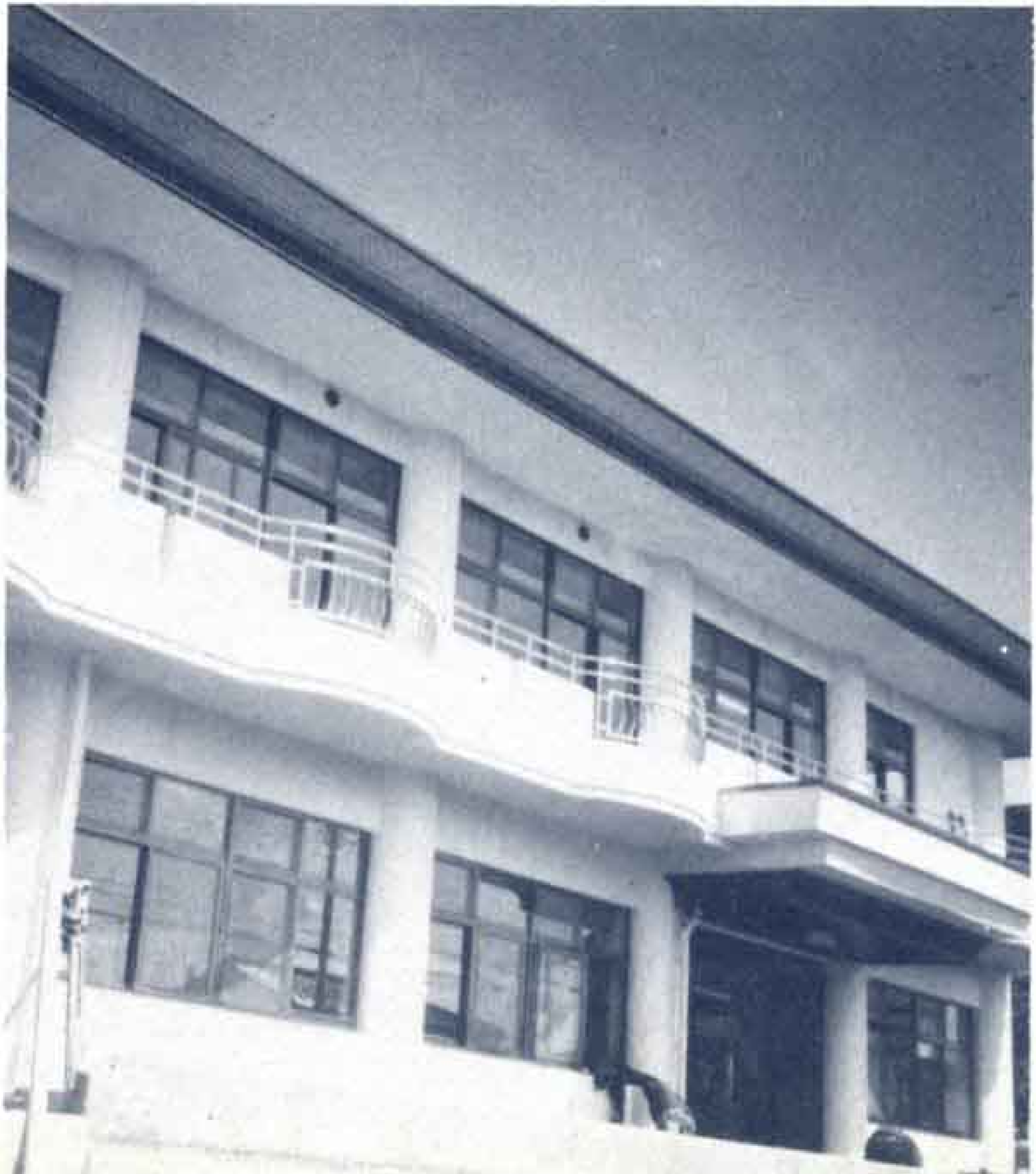
原田公民館 鉄筋コンクリート 二階建て 左
