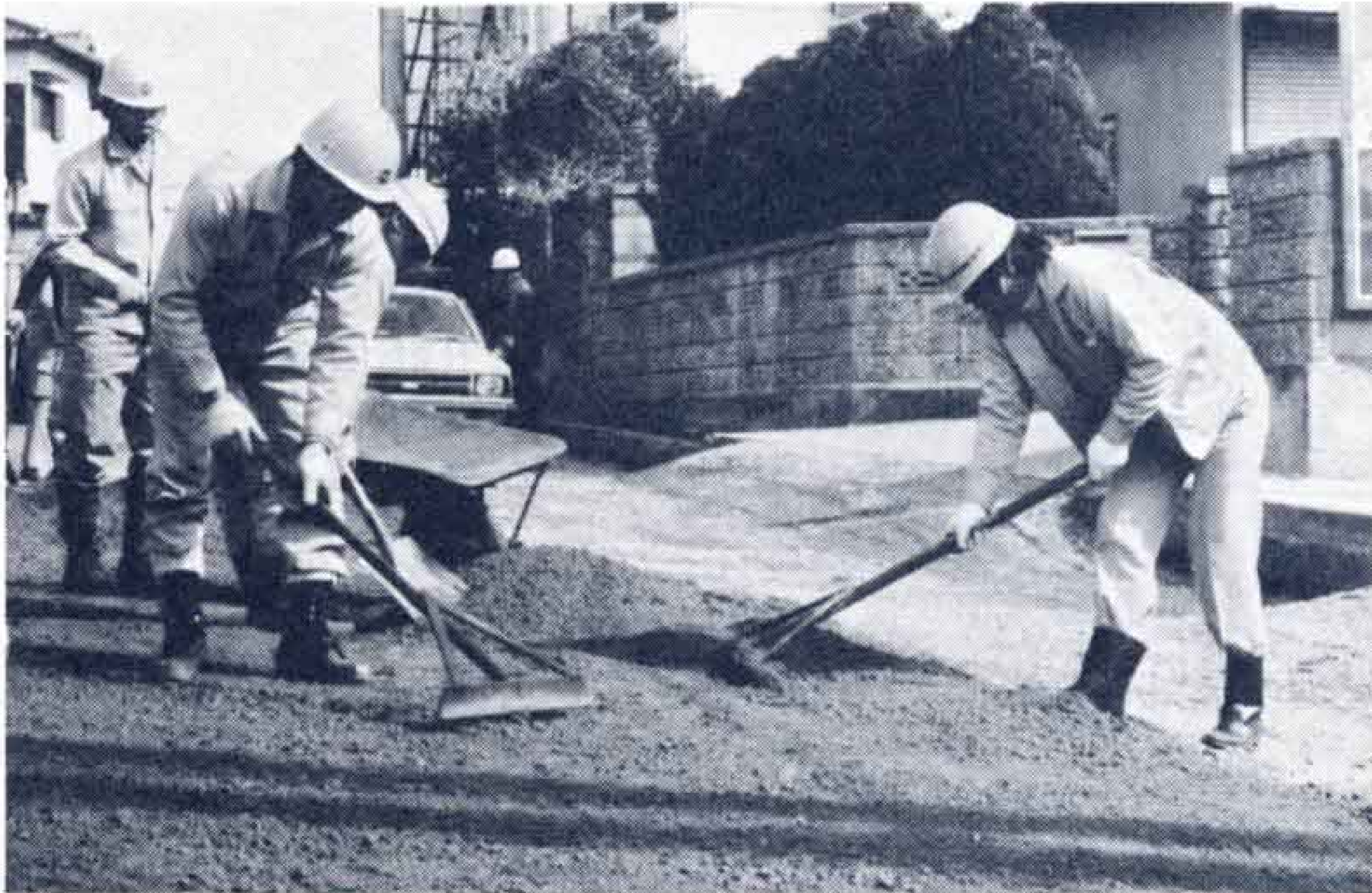
▽焼却灰、碎石、乳剤を混ぜ路盤づくり
