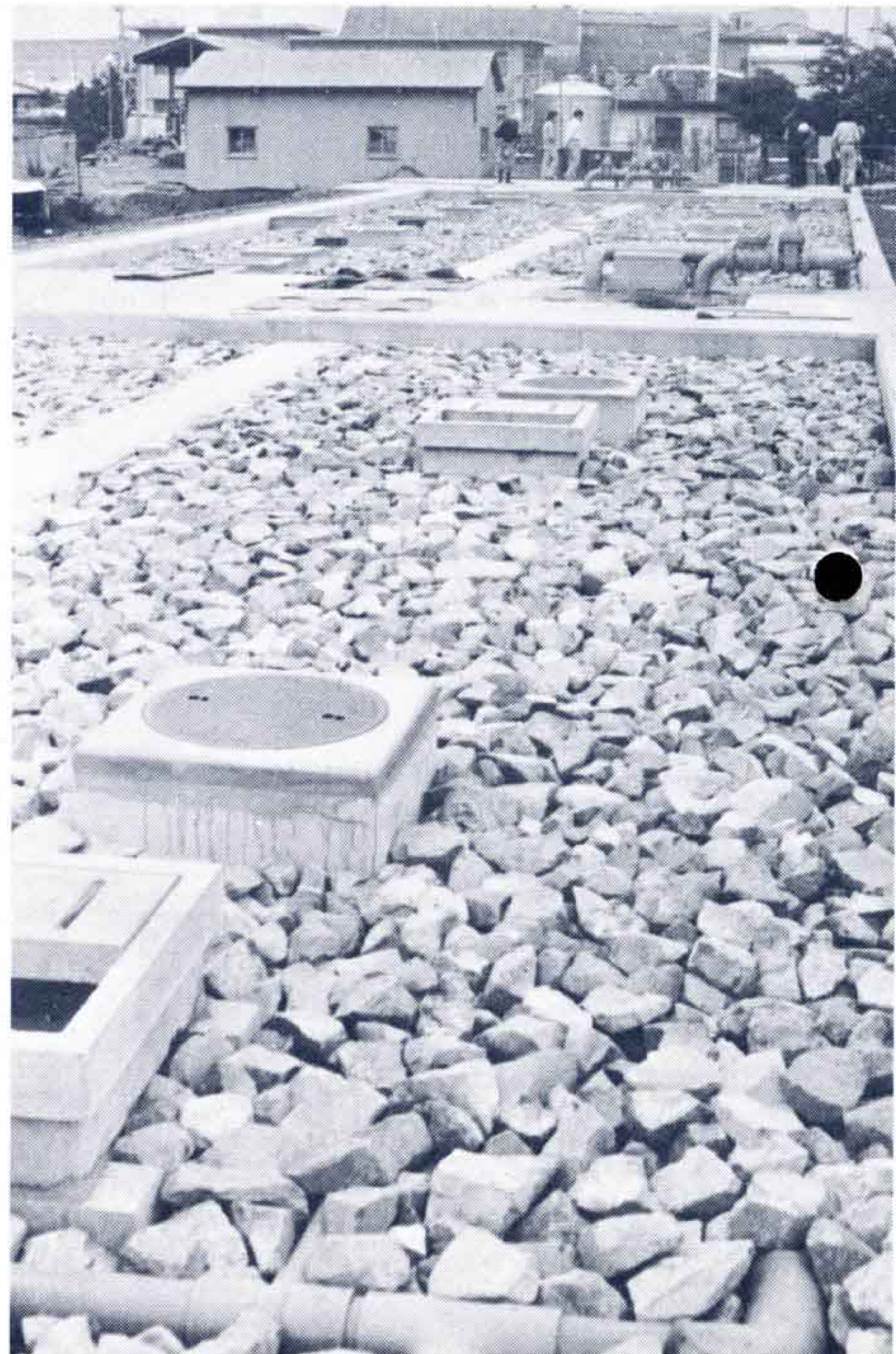
割石を敷き詰めた「礫間接触酸化法」
