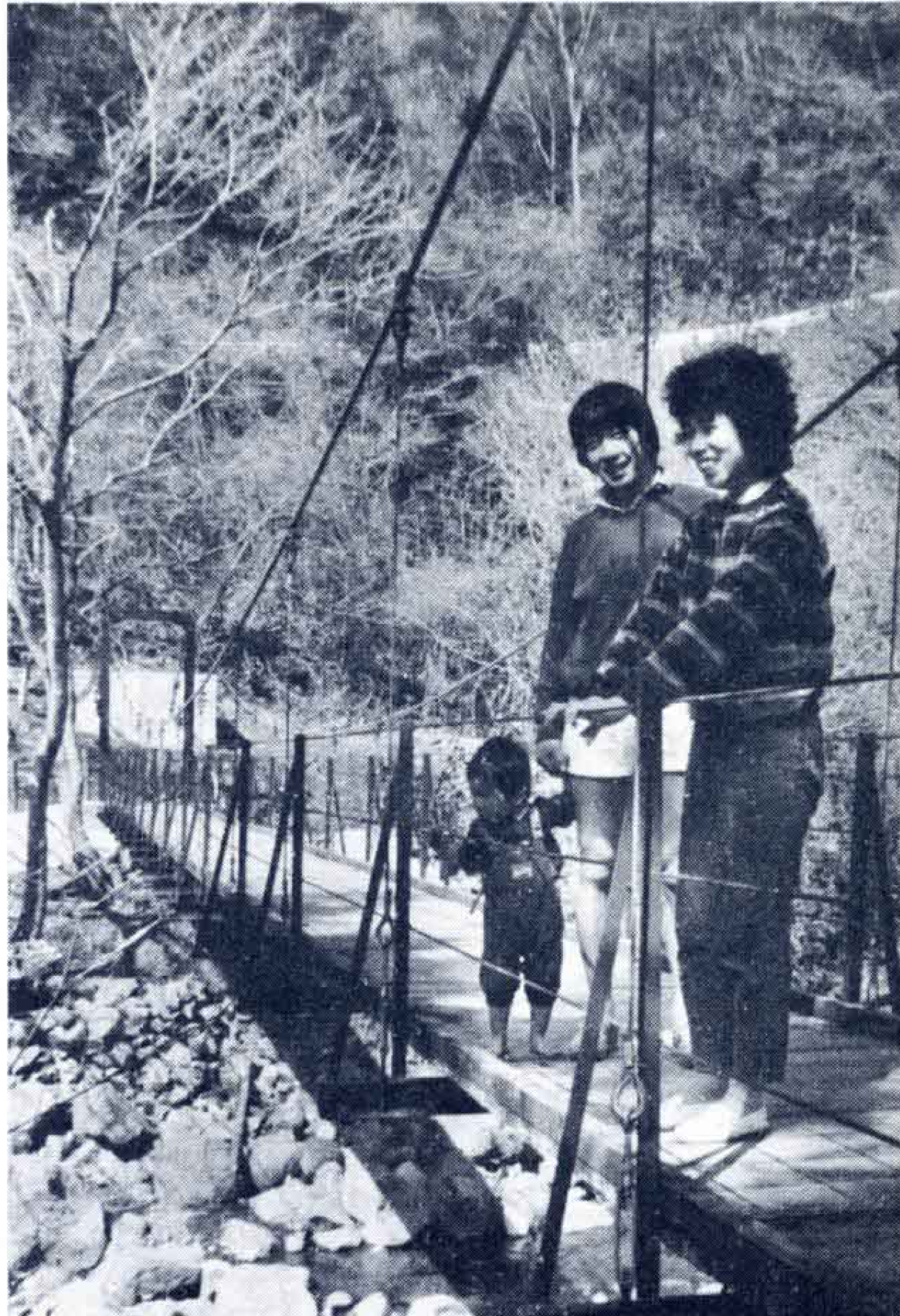
〔滝下に設けられた“滝見橋”は目玉の1つ〕
