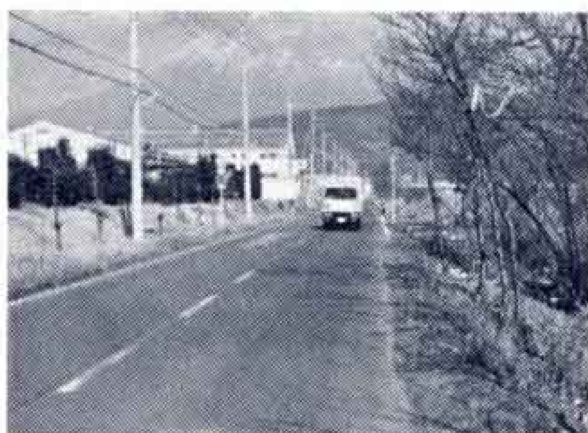
浮島工業団地東側
