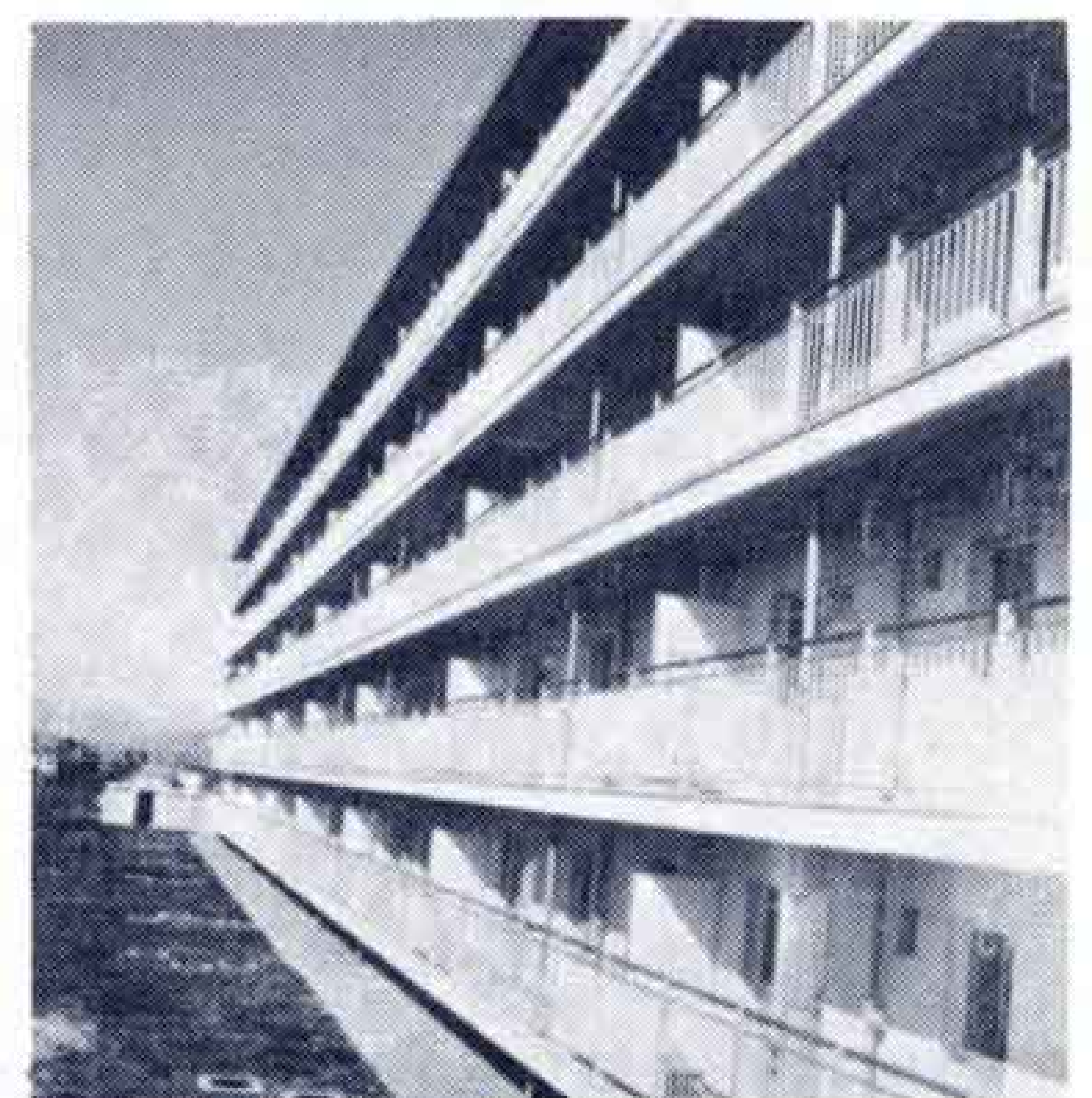
新設の富士見台市営住宅
