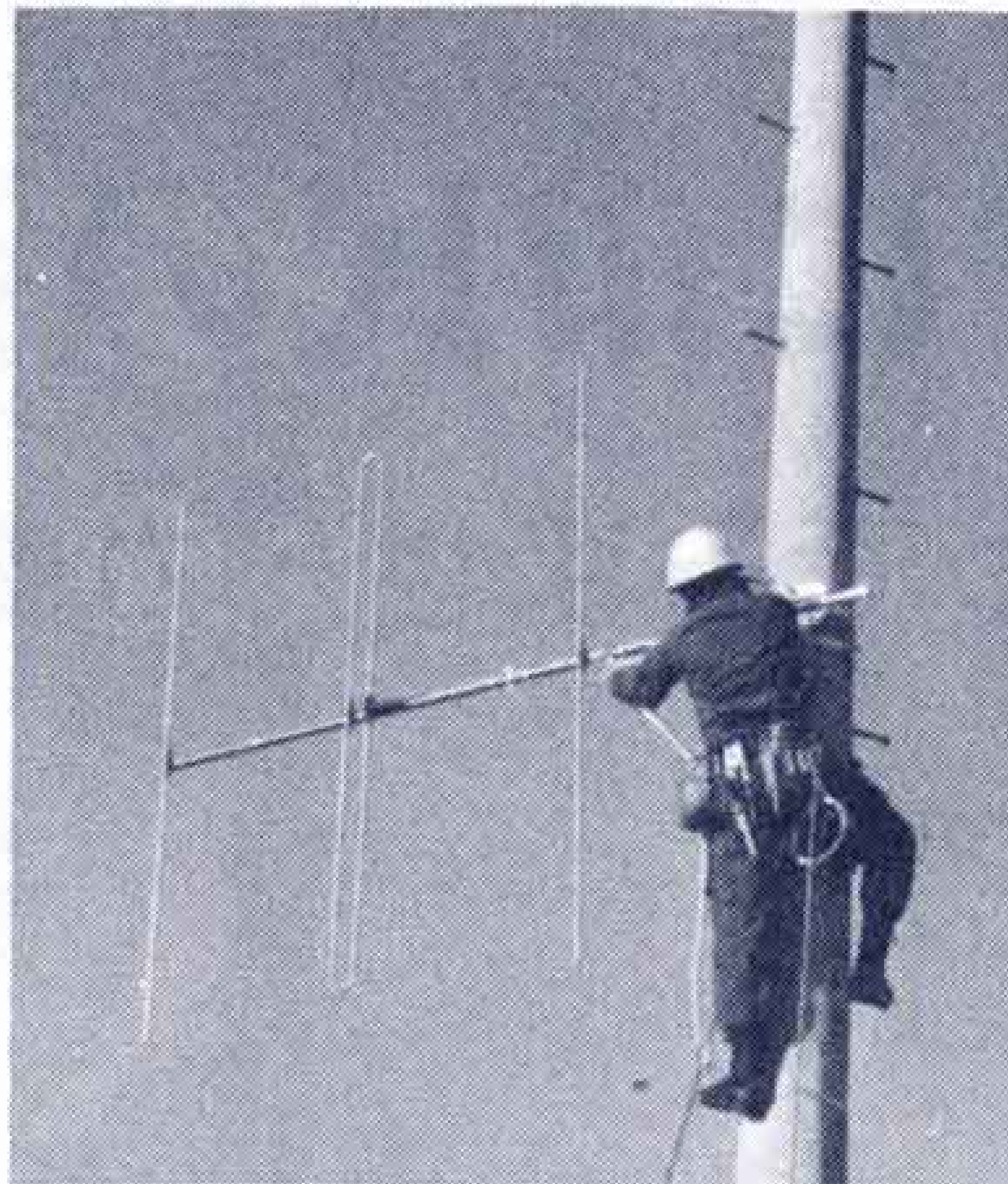
▲アンテナ取替え中の広報塔
