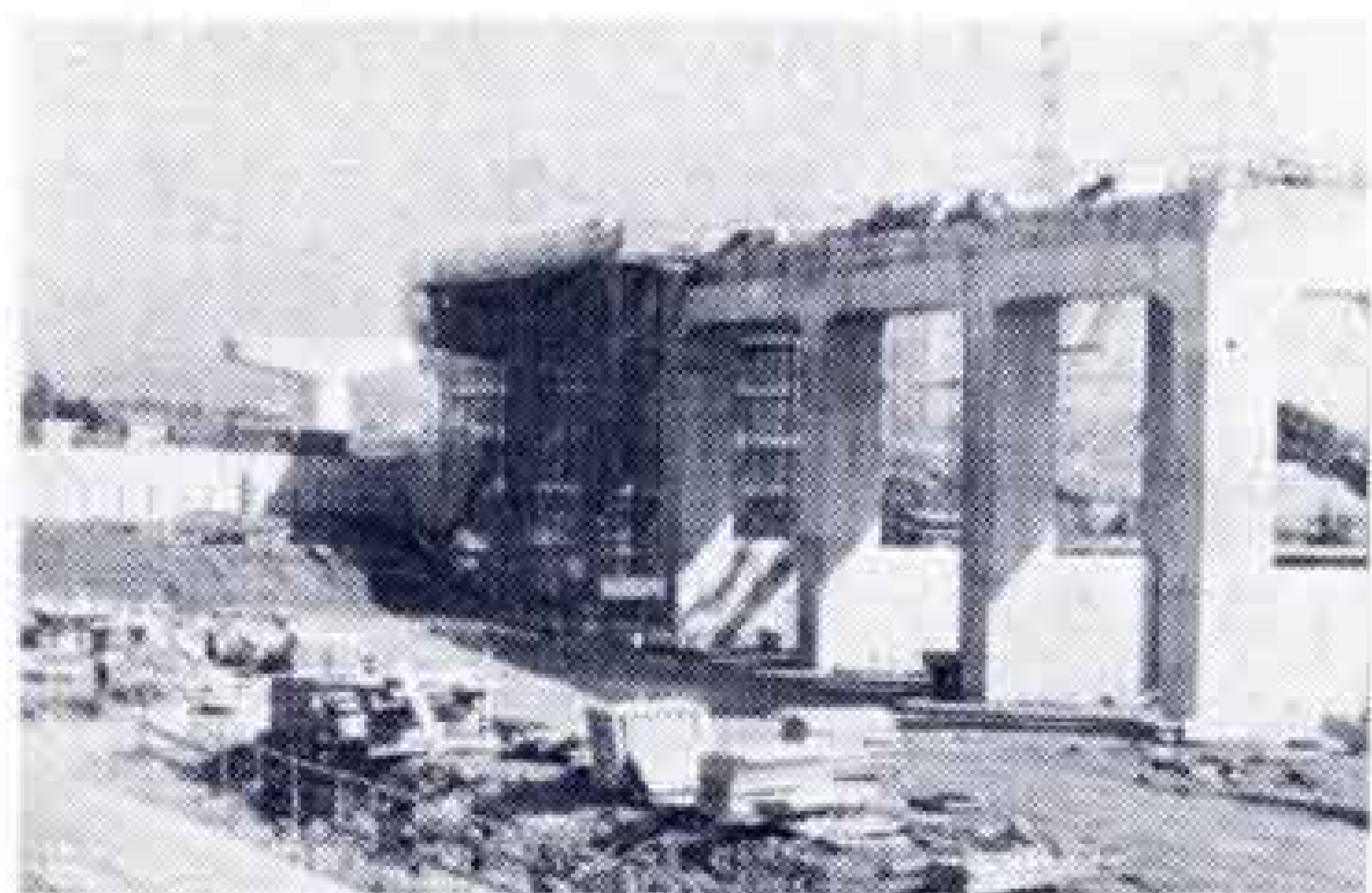
西富士道路の建設工事(東名インター東側)
