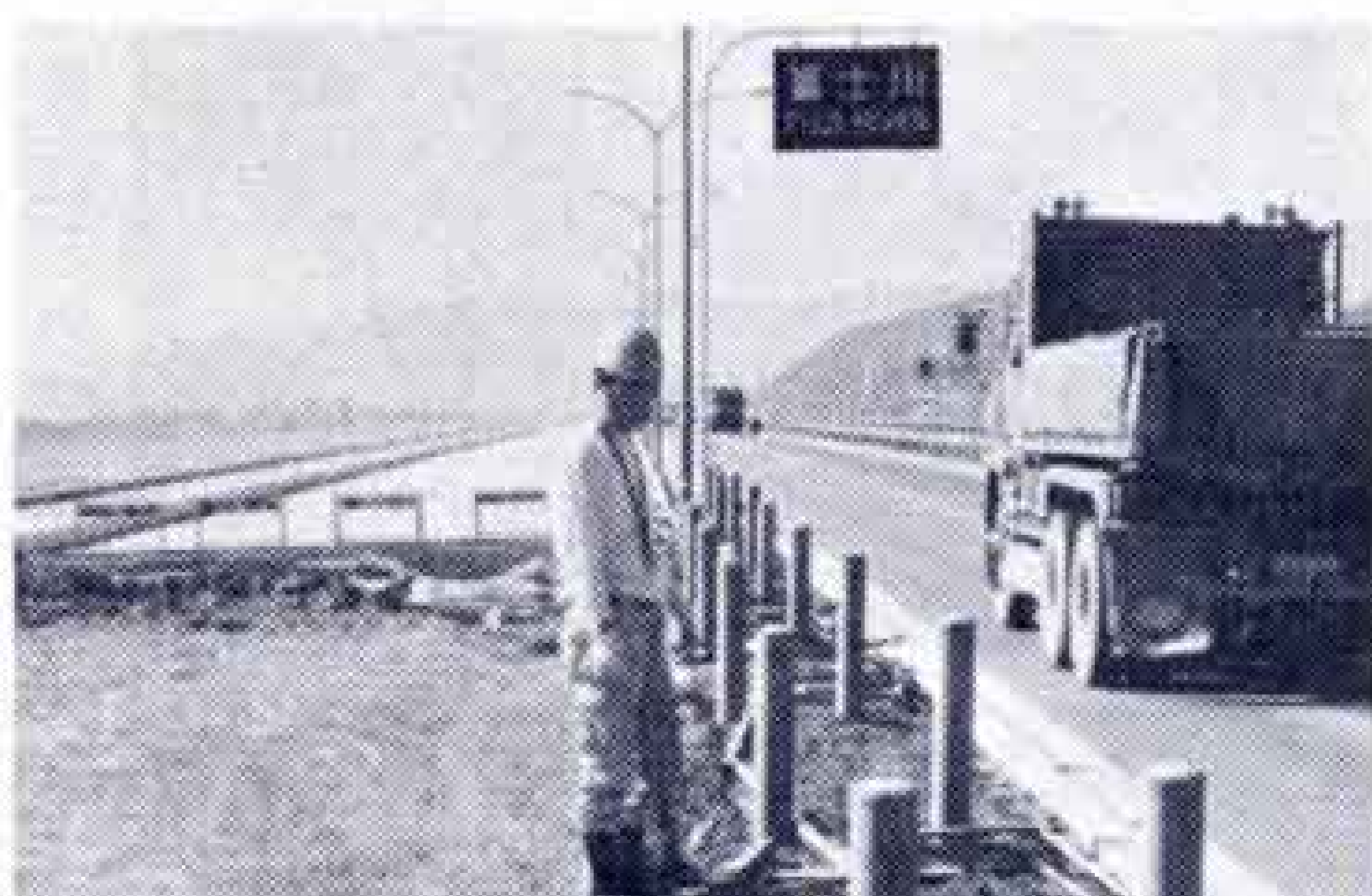
拡幅された新富士川橋
