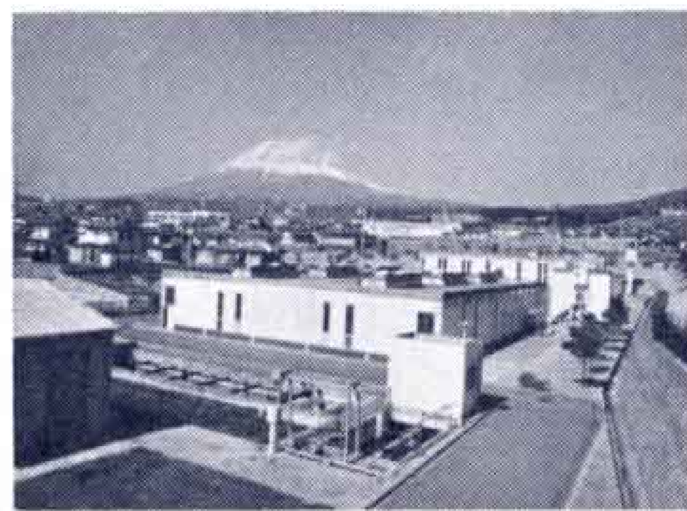
富士見台下水処理場
