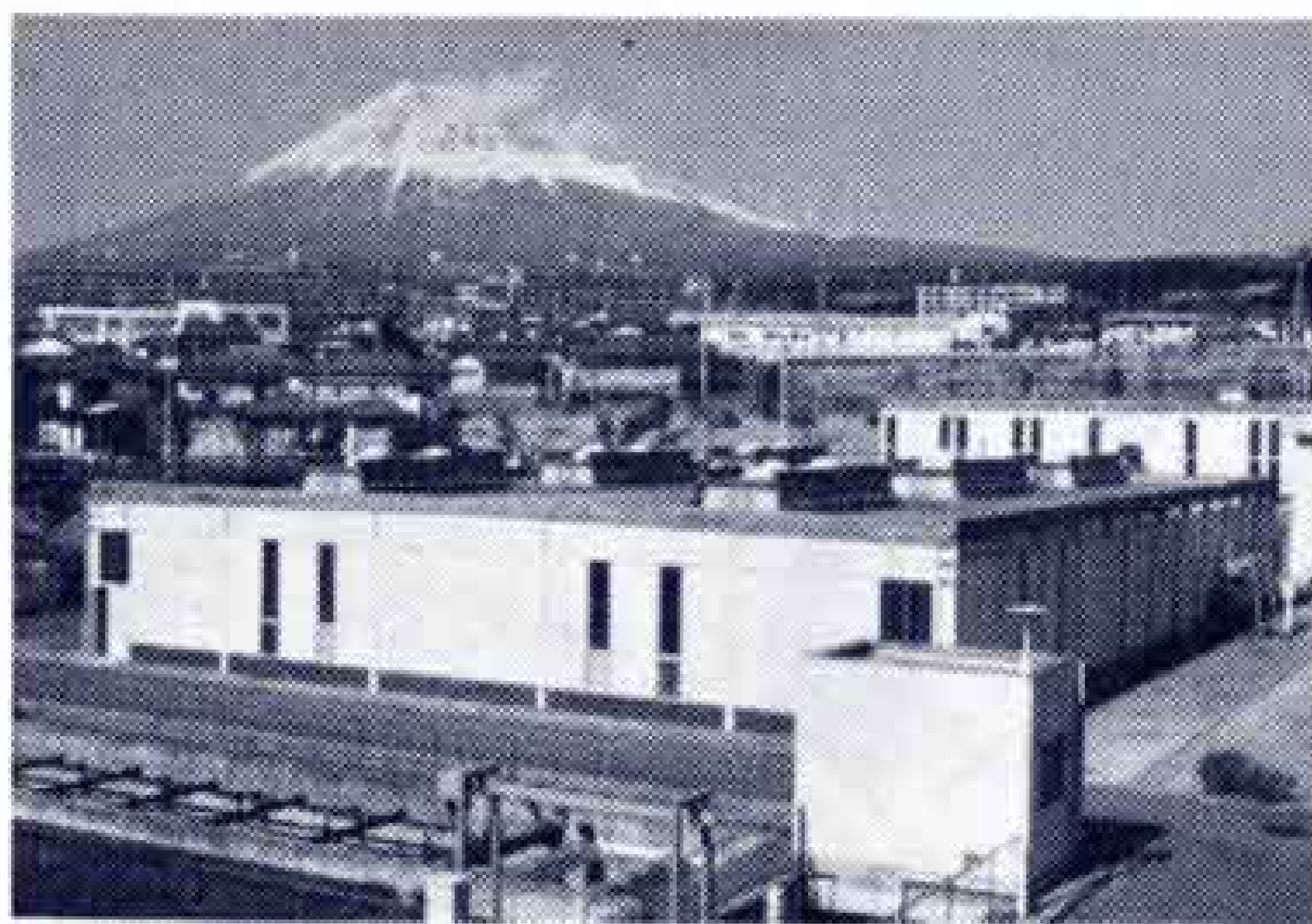
【富士見台下水処理場】
