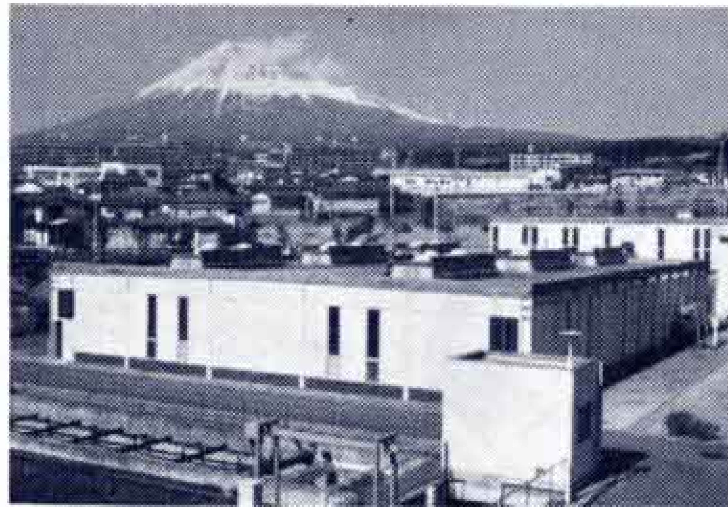
【富士見台下水処理場】
