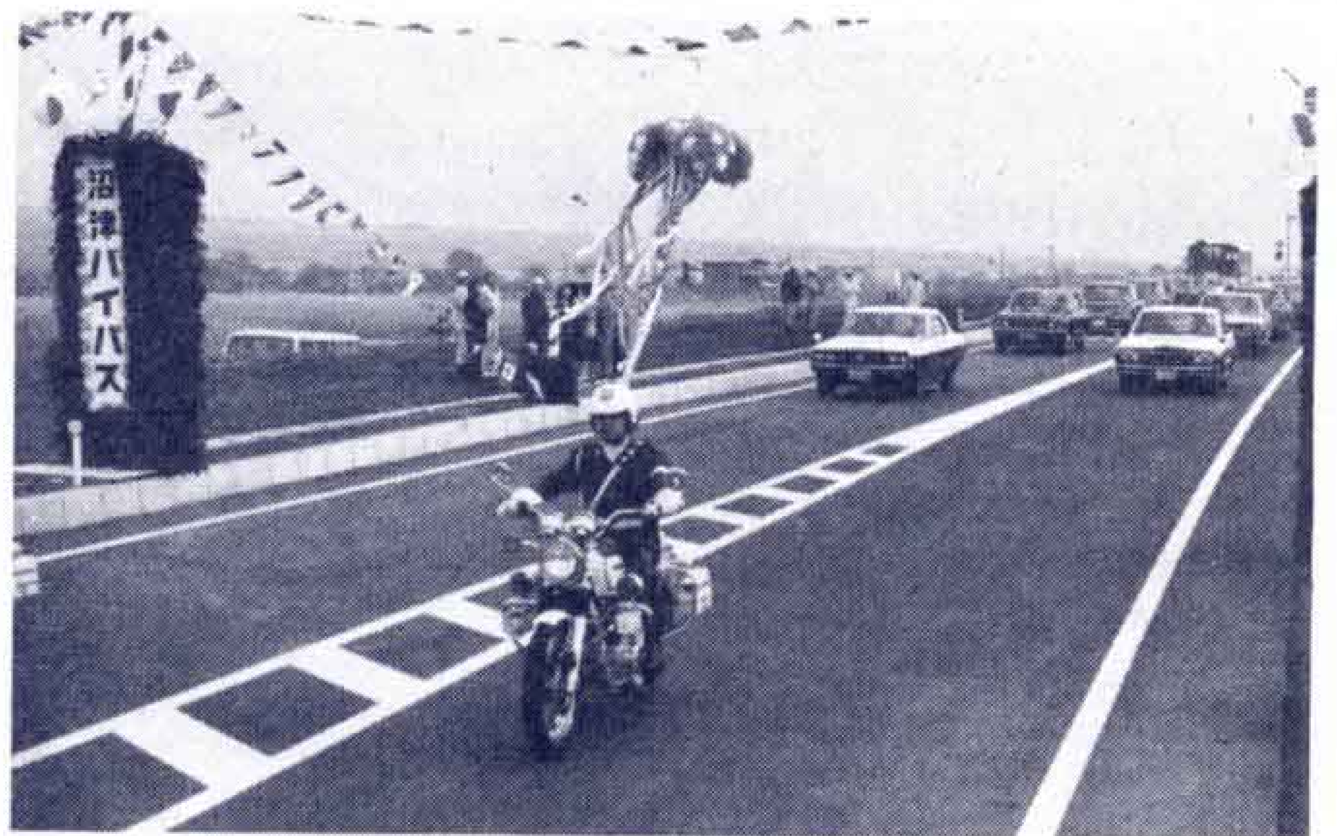
【写真・沼津バイパスの開通式】
