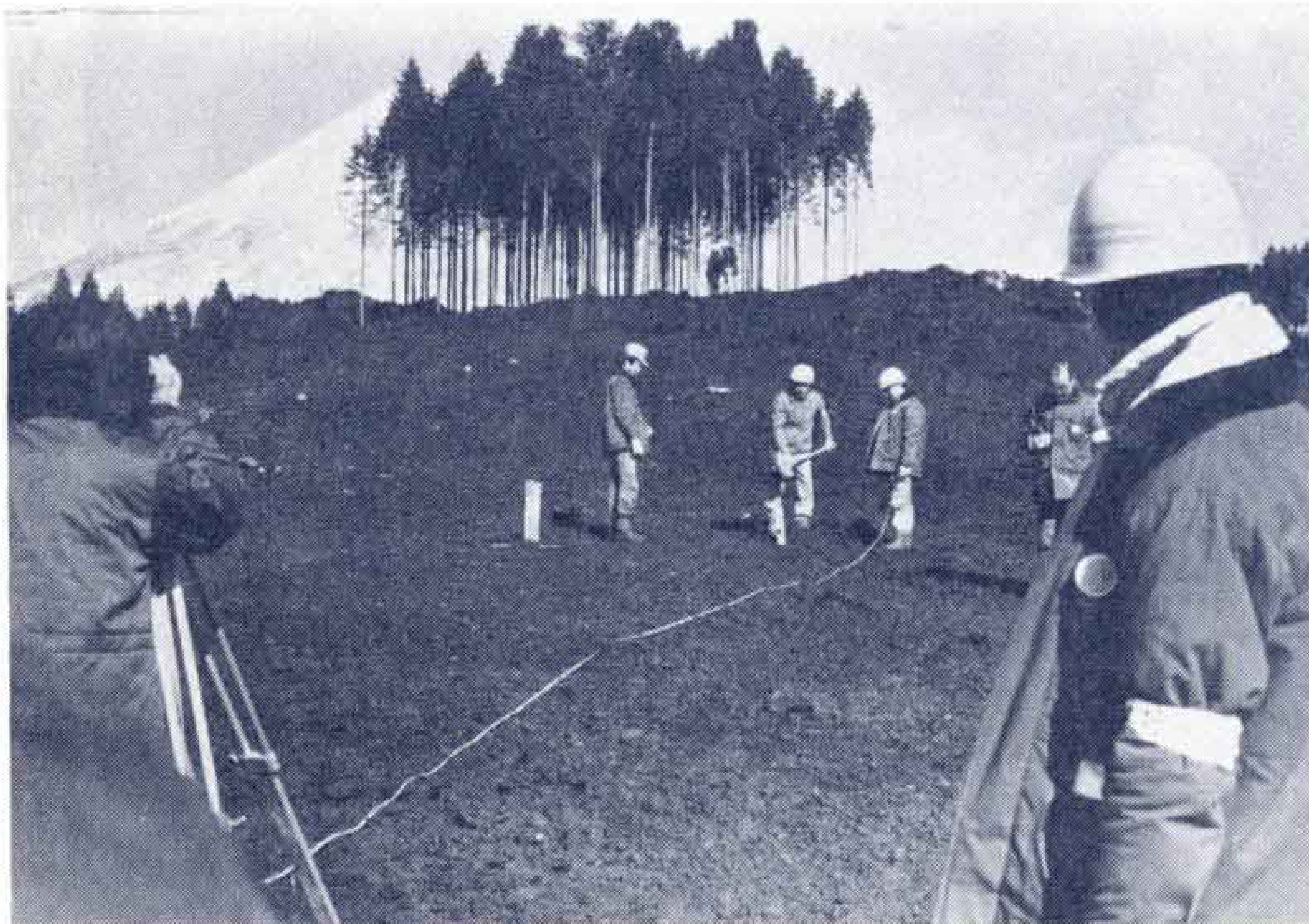
【造成中のゴルフ場内で公道や河川の測量を行う係員】
