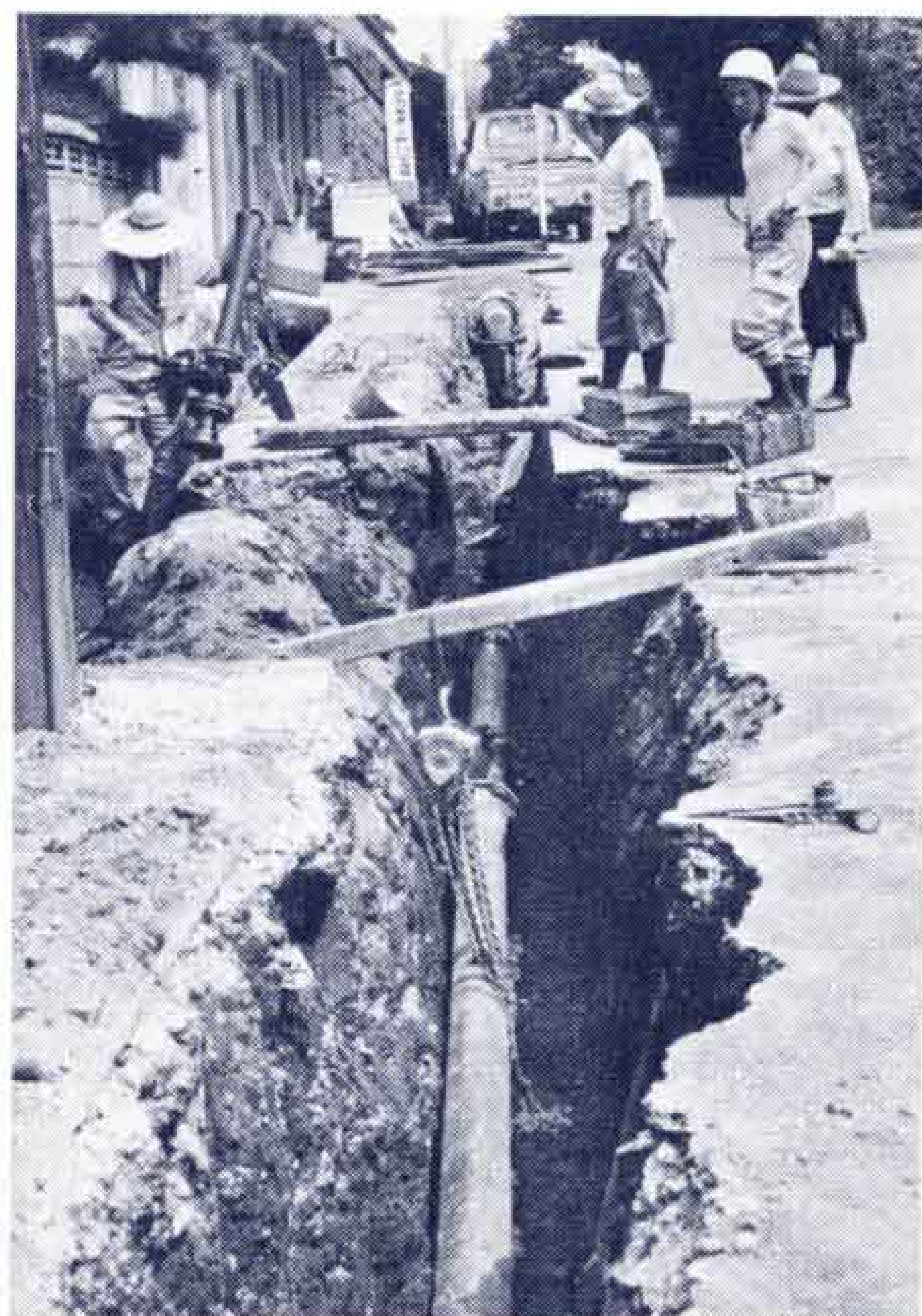
【47年度は4500mの配水管を布設】
