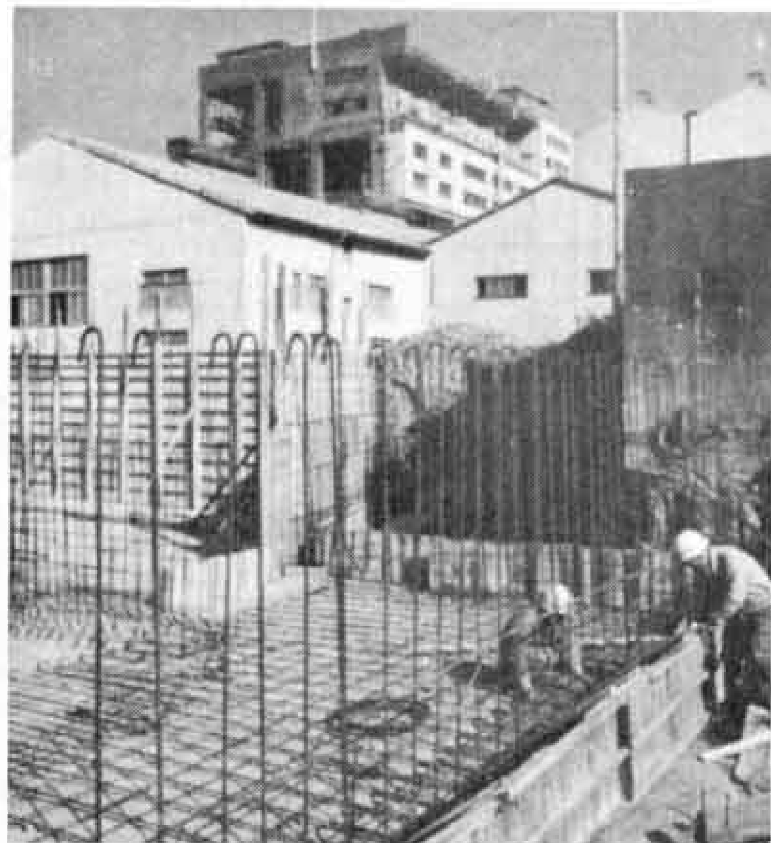
【工場から排出される水質を保つために 中和槽、沈澱槽などを拡充しています】
