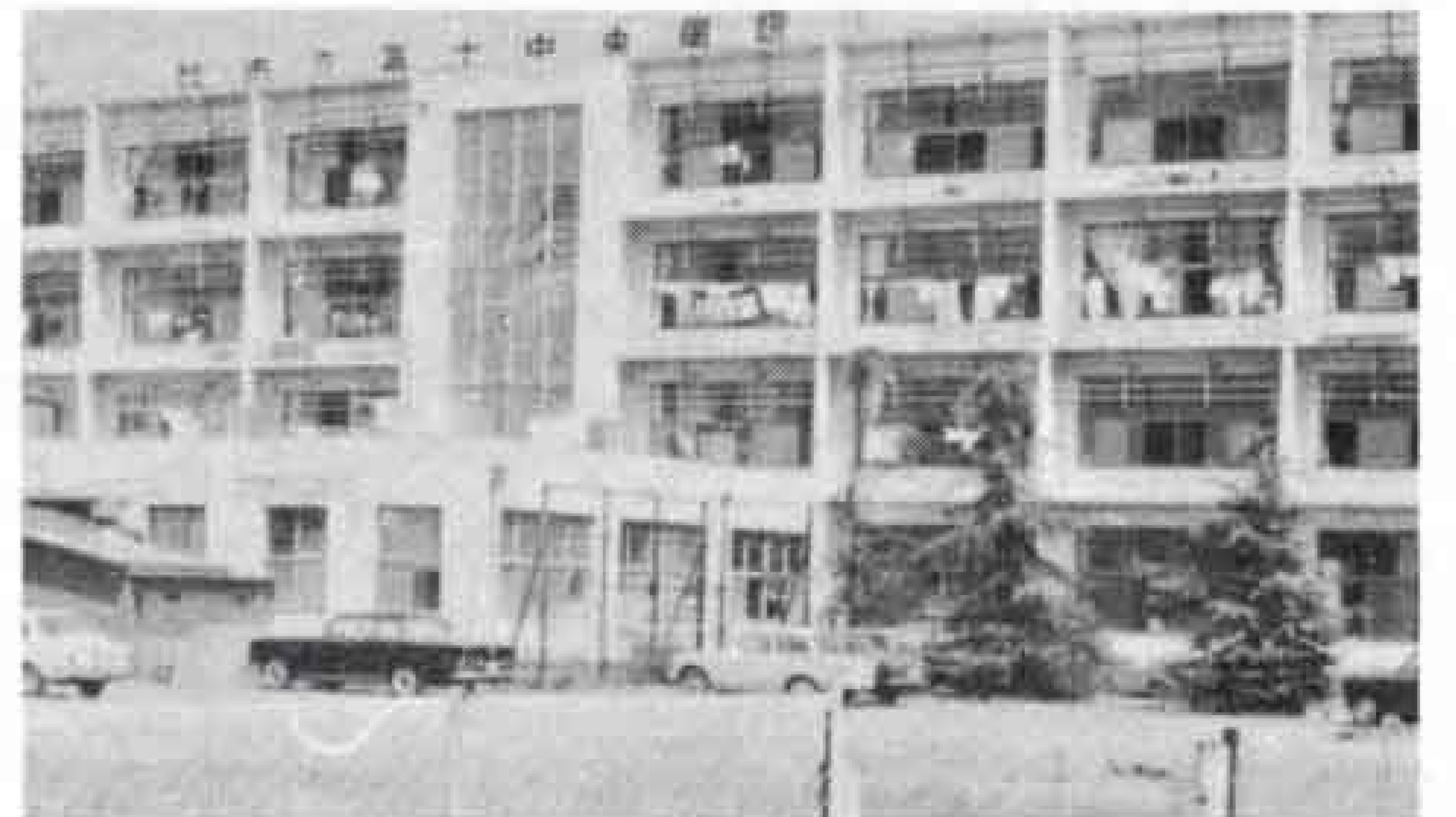
【写真は中央病院南側の建設地】
