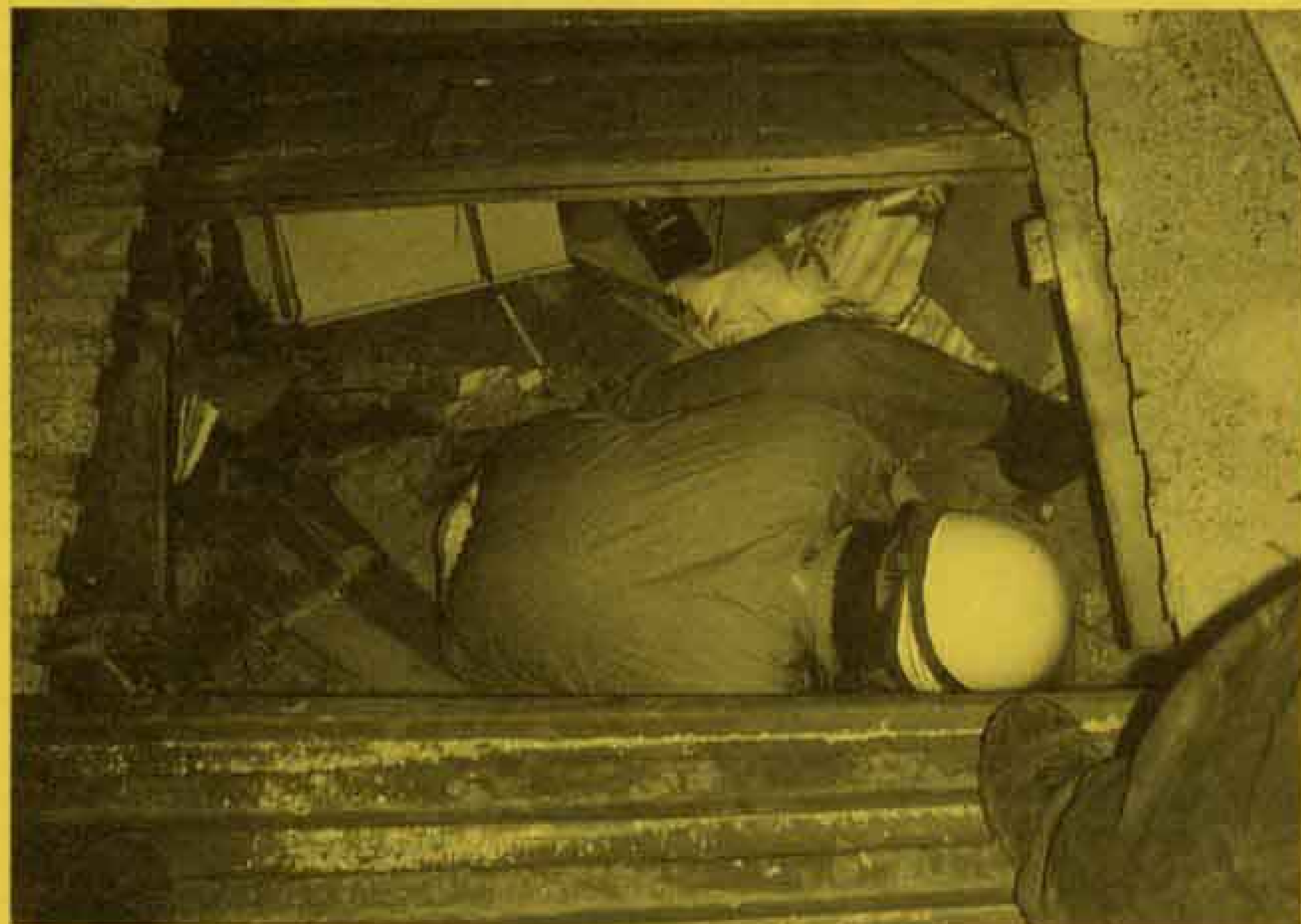
↑建物の下敷きになっている人の救出に当たる救助隊
