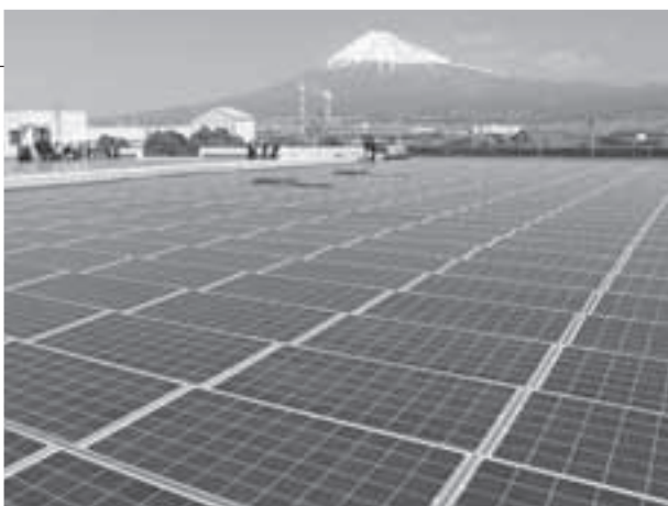
▲西部浄化センター屋上の太陽光発電所
