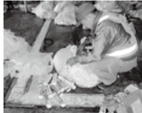
▲混入した廃プラスチック類
