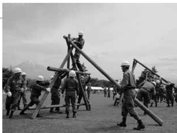
▲長い丸太を三角形に組む水防工法「川倉」を行う訓練参加者
