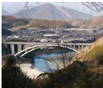
▲新東名高速道路新富士川橋
